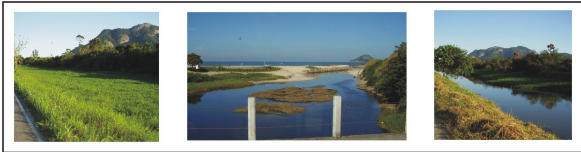
Figura 4: Canal do Rio Morto desde nas proximidades do assentamento e na sua foz, na Praia da Macumba – Rio de Janeiro.
